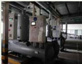
嘉定工厂引入了全新节能型冰水机组，采用一级能效标准的变频压缩机技术，既确保了优良的制冷性能，又显著降低了电量消耗，实现年节约用电量40.8万千瓦时。
