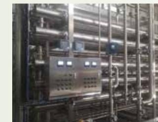
◆ 宜兴工厂开展水处理回收项目，利用 RO 系统、超滤系统对 RO 膜、超滤膜、碳罐清洗水进行回收处理重新利用，年节约用水约 10.2 万吨。
