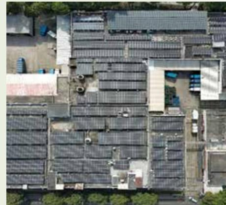
2023年10月19日，深圳工厂光伏发电项目破土动工，并已于同年12月19日圆满完成了全容量并网任务。该项目巧妙利用了华润饮料园区内综合楼屋顶等空间，构建一座总装机容量达888kWp的分布式光伏电站。项目建成投产后，预计每年可提供清洁电能105.8万千瓦时，相当于减少约836.34吨二氧化碳排放。
